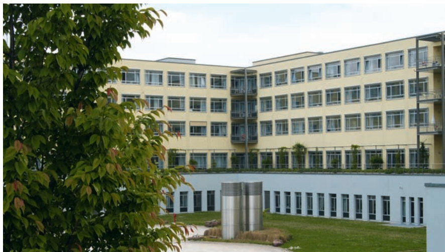
Frischlufthquelle: Filtertürme vor der Medizinischen Klinik
